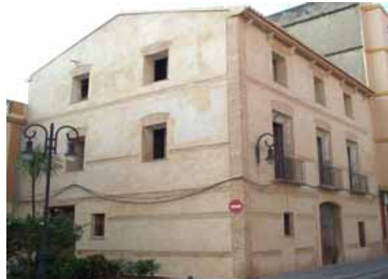
Casa del carrer Coladors en procés de restauració.
